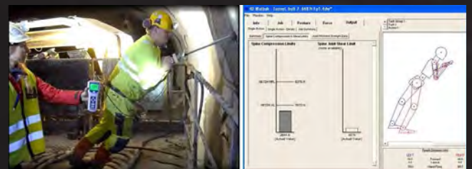
Figur 23 Installation av kamstålsbult i snett uppåtriktat läge. Maximal uppmätt tryckkraft 668 N. Biomekanisk simulering kompressionskraft i ländryggen uppgick till 2684 N (lägre än NIOSH rekommenderade insatsvärde).
