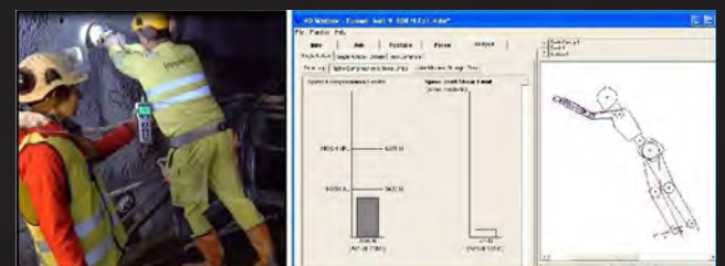
Figur 24 Installation av glasfiberbult i snett uppåtriktat läge. Maximal uppmätt tryckkraft 608 N. Biomekanisk simulering kompressionskraft i ländryggen uppgick till 2885 N (lägre än NIOSH rekommenderade insatsvärde).
