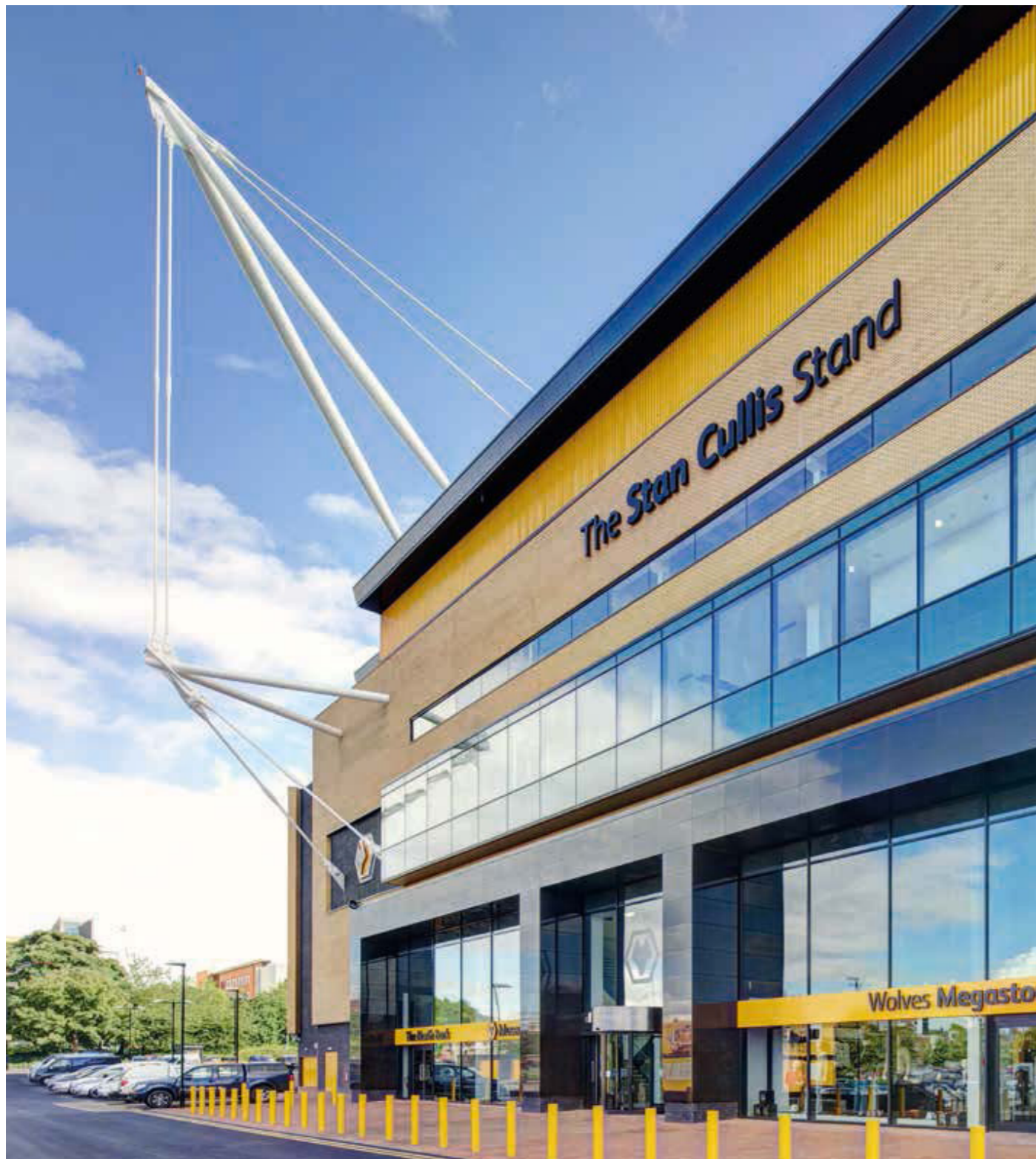
ASDO540-S dragstag var det enda system som användes som stöd för de höga belastningarna vid byggnationen av den nya läktaren på Wolverhampton Football Club i Storbritannien. Systemet kan förspännas på plats.
