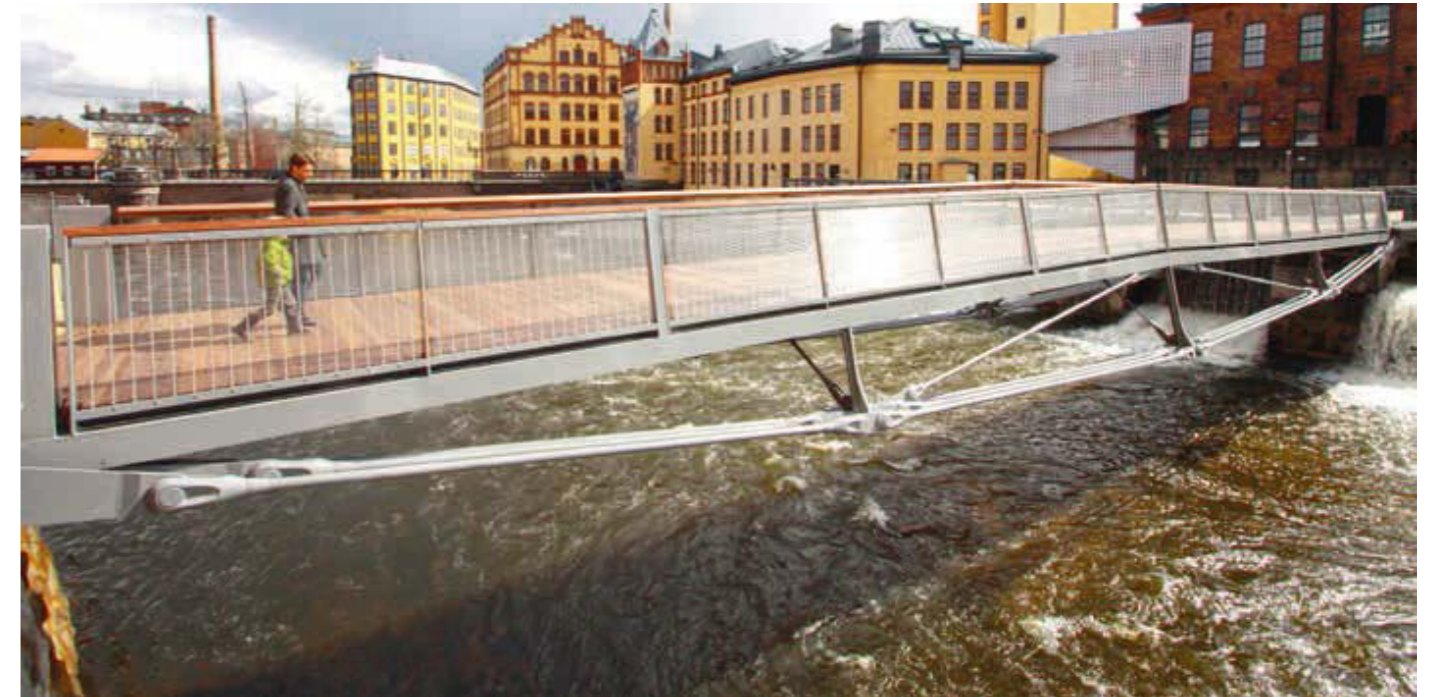
ASDO 540-S M56 förankringsstag har använts för att bilda bärelement i det här fackverket som återfinns i gångbron i Käkenhus, Norrköping, Sverige.
