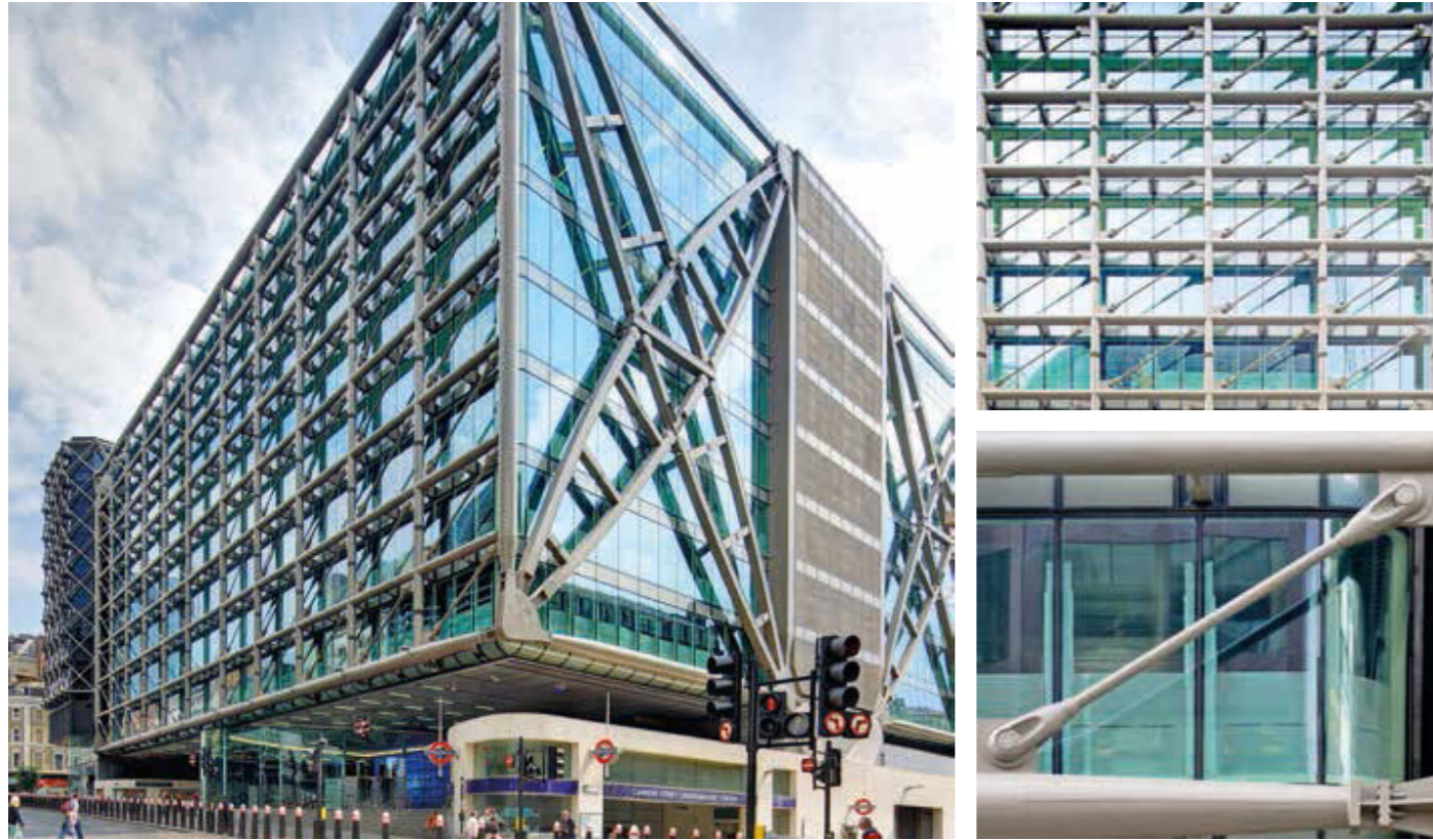
ASDO 540-S förankringsstänger M76 till M160 användes som dragstag i de fackverk som utgör delar av denna unika och konstruktionsmässigt krävande kontorsbyggnad vid Londons Cannon Place.
