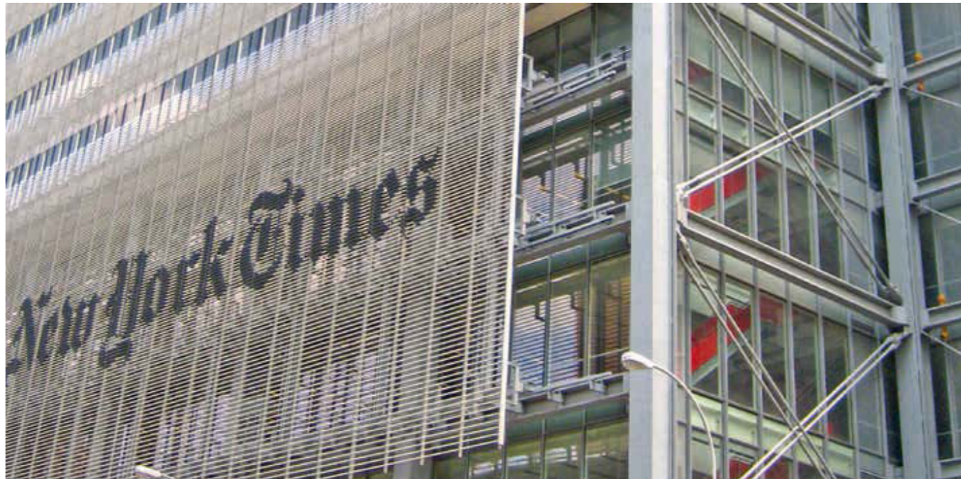
Parallella ASDO 540-S dragstag användes som förankringar i New York Times nya huvudkontor på 52-våningar.
