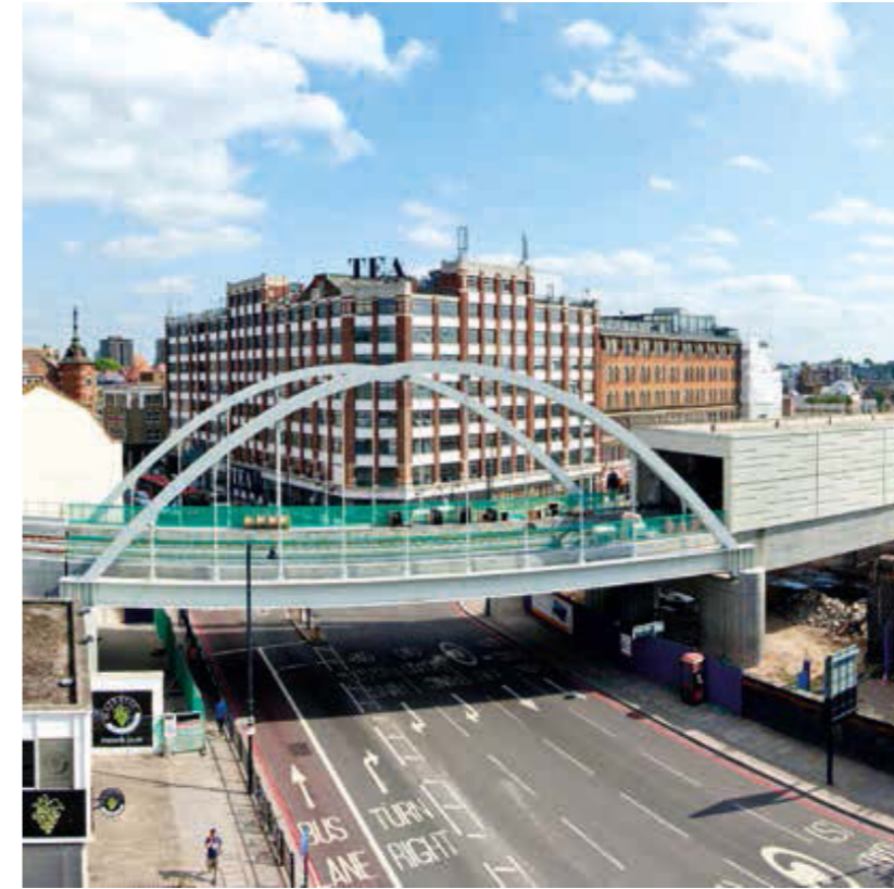
ASDO 540-S M90 dragstag används som bärelement på East London Lines järnvägsbro i Shoreditch. Förutom att genomgå rigorösa förundersökningar så utmattningstestades systemet också i 2 miljoner cykler.
